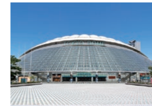
東京ドーム 空調設備
