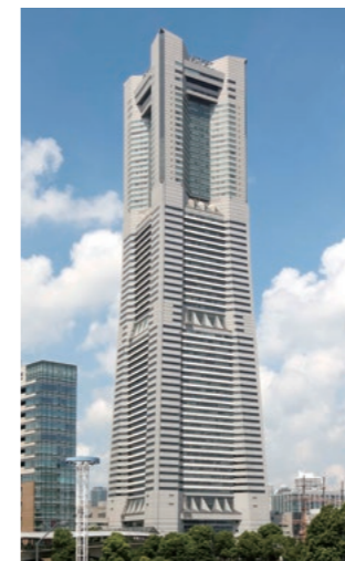
横浜ランドマークタワー 空調設備
