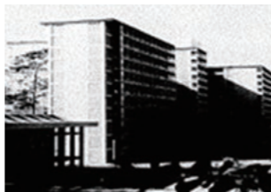
チョーライ病院 空調・衛生設備(ベトナム)
