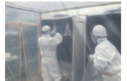
RCF含有製品の撤去作業
