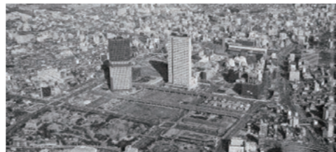
新宿副都心地域 地域冷暖房設備
