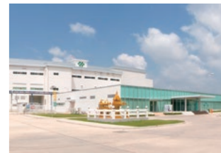
タイ協和バイオテクノロジーズ プラント設備・土木建築(タイ)
