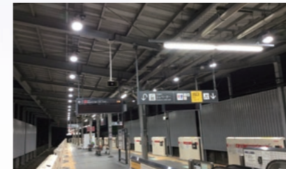
LED化された駅舎
