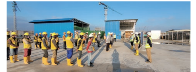
施工現場での朝礼(カンボジア)
