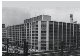
新大手町ビル 冷暖房設備
